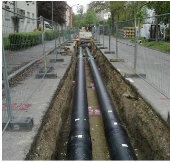
Abbildung 3: Links: Erdverlegte Rohre im Bauzustand. Rechts: schematische Skizze der Winkler-Bettung
